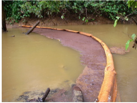
IMGPO718.JPG quebrada pucacungayacu Balisa Flotante con Absorbent
